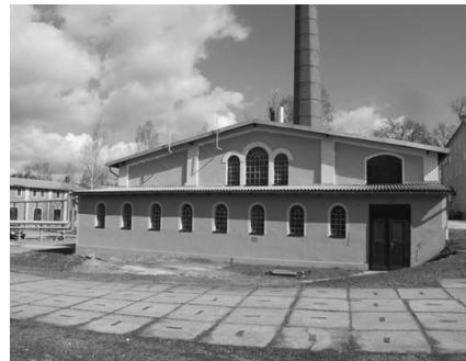
Abb. 17: Maschinenhaus zur Dampferzeugung des Riemenantriebs der Web- und Textilveredelungsmaschinen von ADC (Foto: Jos Tomlow 2004)
