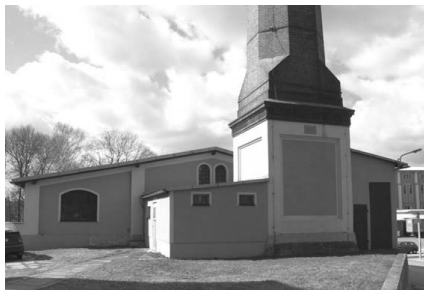
Abb. 18: Schornstein vom Maschinenhaus mit Badestube (Foto: Jos Tomlow 2004)
