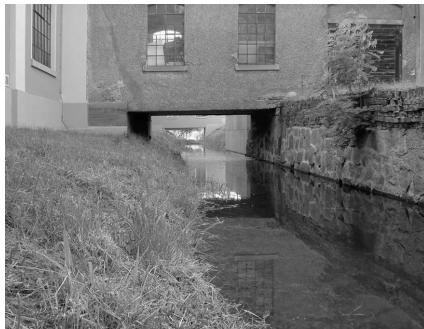
Abb. 16: Blick über den Petersbach zwischen flankierenden Fabrikhallen (Foto: Jos Tomlow 2004)
