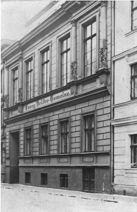
Abb. 6: Das fertiggestellte Gebäude in der Vorwerkstraße (Foto: Privatbesitz)
