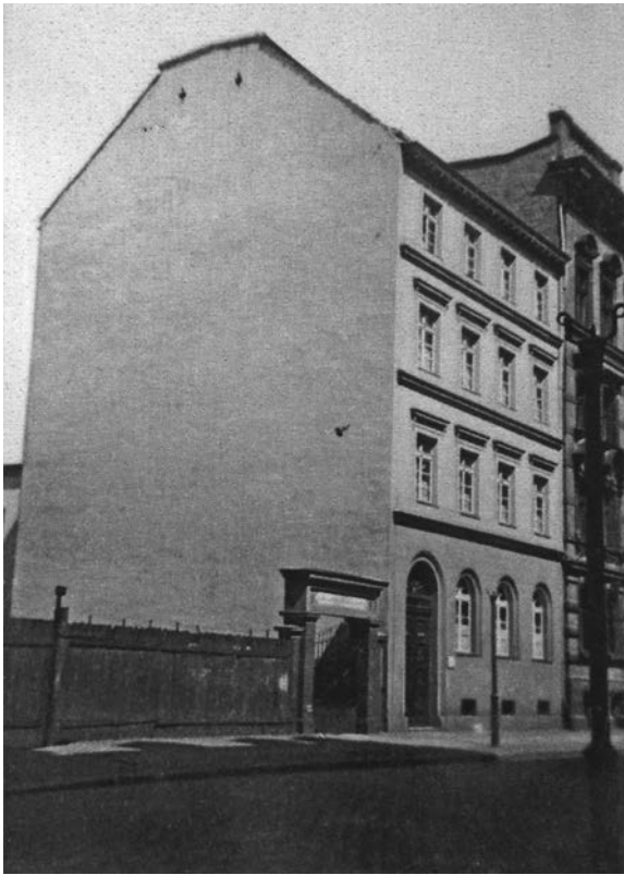
Abb.5: Das fertiggestellte Gebäude in der Vorwerkstraße (Foto: Privatbesitz)
