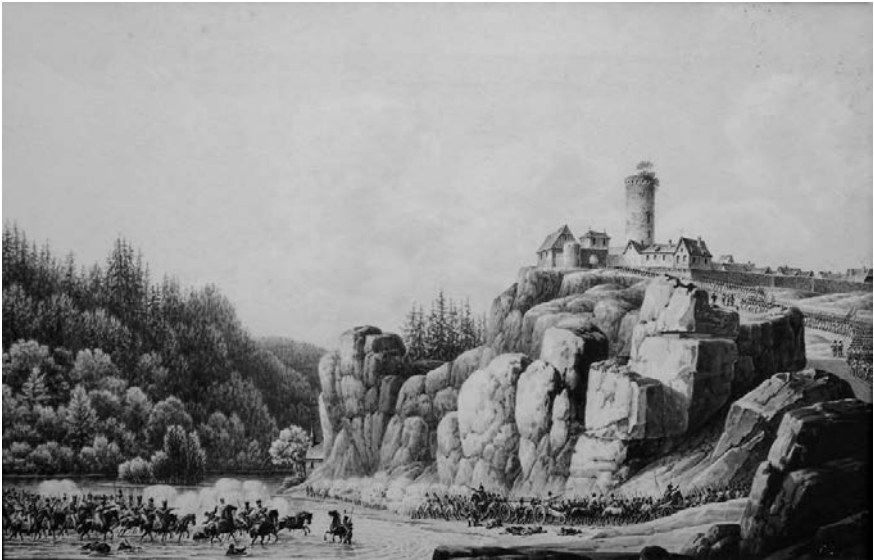
Abb. 2: Übergang über die Saale bei Saalburg 1806.
