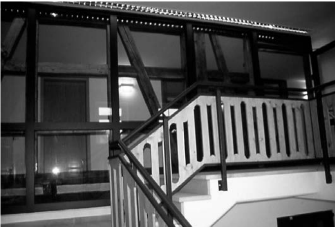
Neues Treppen- haus im Bür- gerhaus unter Verwendung originaler barocker Geländer
