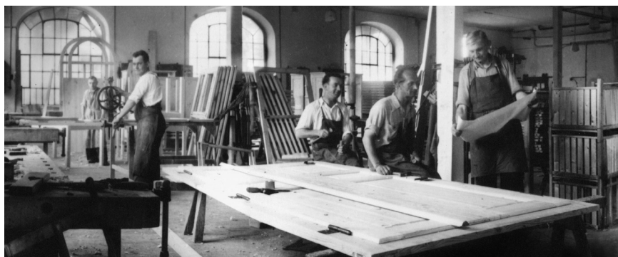
Abb. 7: Tischlerei der Deutschen Brüder-Unität 1952. In der Werkstatt im Erdgeschoß der ehemaligen Dürningerschen Bleiche ist eine Emporentür für den Wiederaufbau des Herrnhuter Kirchensaales zu erkennen. Stehend mit Plan neben der Säule der Tischlermeister Georg Martin. Foto: Karl Siebörger, Firmenarchiv Herrnhuter Holzmanufaktur.
