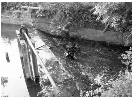
Abb. 4: Wehr in moderner Ausführung mit Vorrichtung zu Wasserregulierung (Foto: Jos Tomlow 2004)
