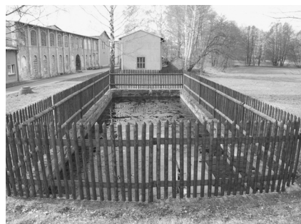
Abb. 5: Brauchwasser- und Feuerlöschteich unterhalb der ehemaligen Bleiche (Foto: Jos Tomlow 2004)
