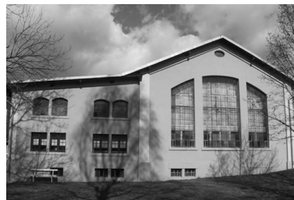
Abb. 19: Ehemaliges Dampfturbinenhaus (Foto: Jos Tomlow 2004)
